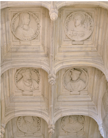
Plafond de l'escalier d'honneur.
