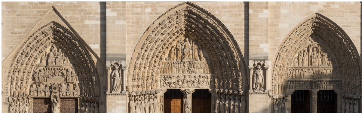
Portails de la façade occidentale © David Bordes/ Cmn
