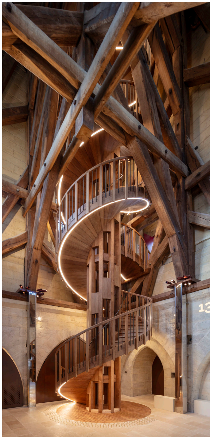
Cathédrale Notre-Dame de Paris, tour sud, escalier à double révolution dans le beffroi montant de la salle des quadrilobes jusqu'aux bourdons © David Bordes / Cmn
