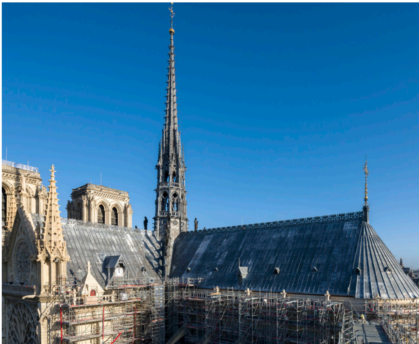
Vue extérieure échafaudage © David Bordes / Cmn
