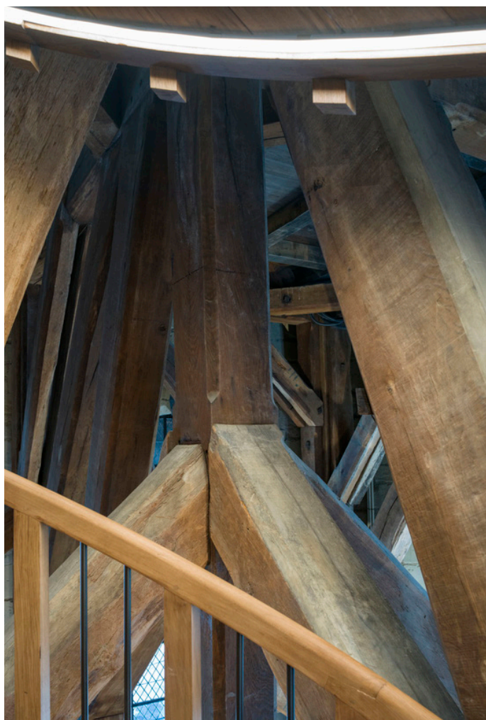
Cathédrale Notre-Dame de Paris, tour sud, la charpente du beffroi vue depuis l'escalier à double révolution, David Bordes / Cmn
